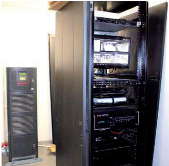
Uno degli ambienti della sala tecnica, nel seminterrato. Il rack, a fianco del gruppo di continuità, contiene un monitor, una centralina RTI, le matrici audio video, i decoder, i server per videosorveglianza e backup.
